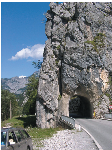
Der Tunnelfels von vorn
